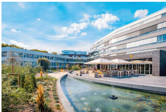
BU: Die Zeichen stehen auf Wachstum. Anfang 2018 wurde das dritte, neu erbaute Firmengebäude in Duisburg bezogen.
